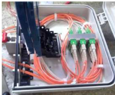
Рис. 3 МРА на базе бокса PBO T1 .
