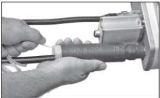
**Важно:** При работе в условиях низких температур (ниже 2 °C), трубка 3М 'Pull'N'Shrink' усаживание трубки будет замедленным. Согревайте трубку руками для ускорения процесса усадки. Перед тем, как укладывать кабель с соединителем в траншею, наполненную водой, подождите 5 минут.
